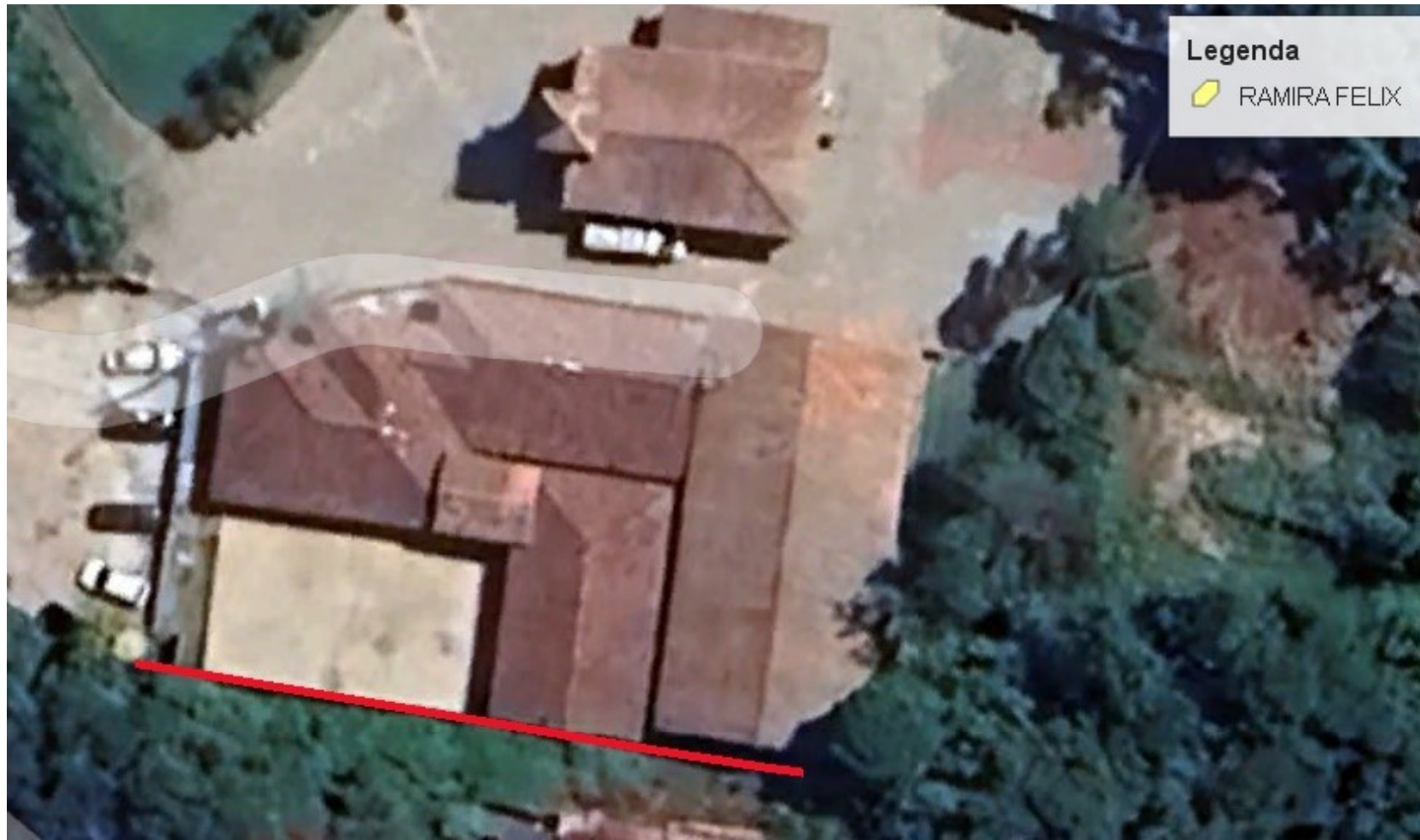
MURO DE CONTENÇÃO
