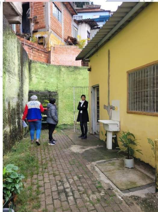
Foto 11 – Área de Serviço, lado esquerdo
