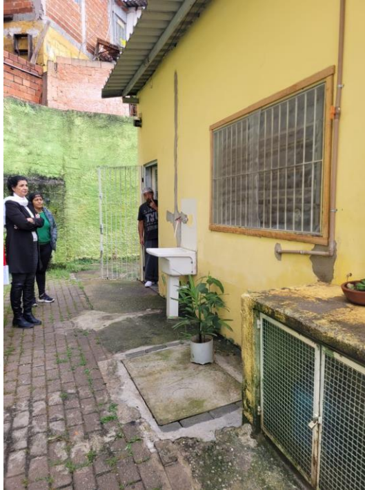
Foto 10 – Área de Serviço, lado esquerdo
