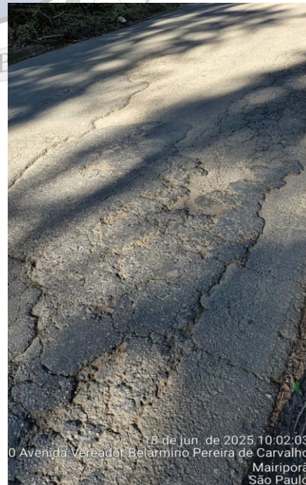
Av. Ver. Belarmino P. de Carvalho – Necessidade de fresa + recape.
