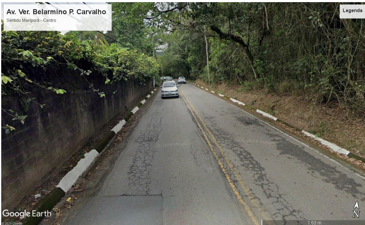
Av. Ver. Belarmino P. de Carvalho – Necessidade de fresa + recape.
